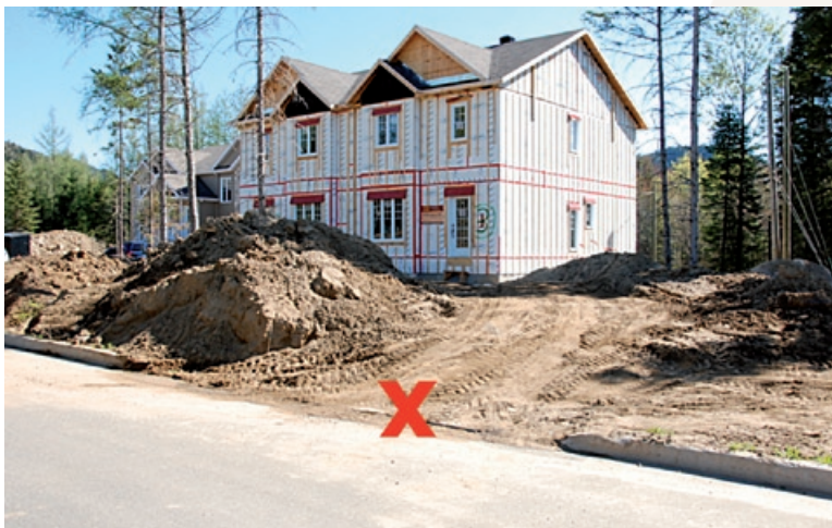
Figure 4 – Accès au chantier sans stabilisation
