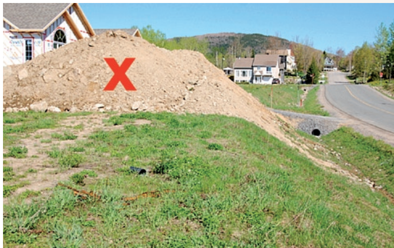
Figure 3 – Entreposage fautif de tas de déblais
